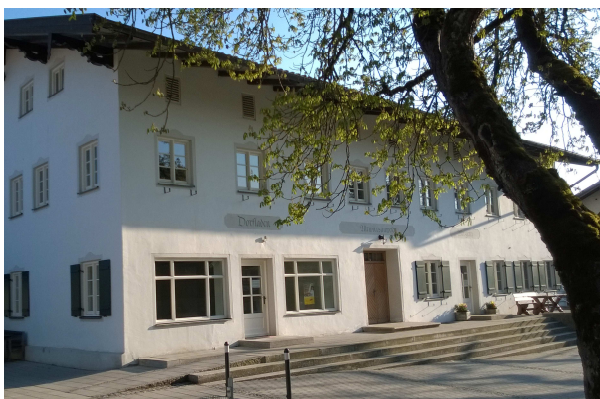
Altwirtsaal, Taubenbergstraße 31, 83627 Oberwarngau
